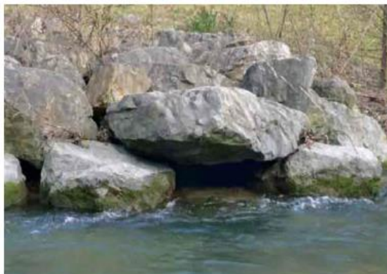
Abbildung 23: Ausführungsbeispiel Fischunterstand aus Steinen (links) aus Holz (rechts) (DURAWA, 2023)
