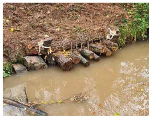
Abbildung 23: Ausführungsbeispiel Fischunterstand aus Steinen (links) aus Holz (rechts) (DURAWA, 2023)
