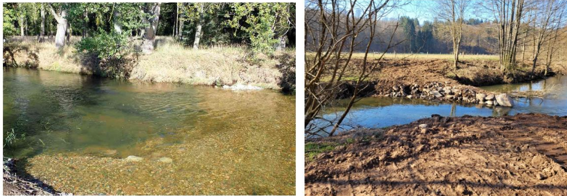
Abbildung 24: Ausführungsbeispiel Kiesrausche (links) aus Steinbühne (rechts) (DURAWA, 2023)
