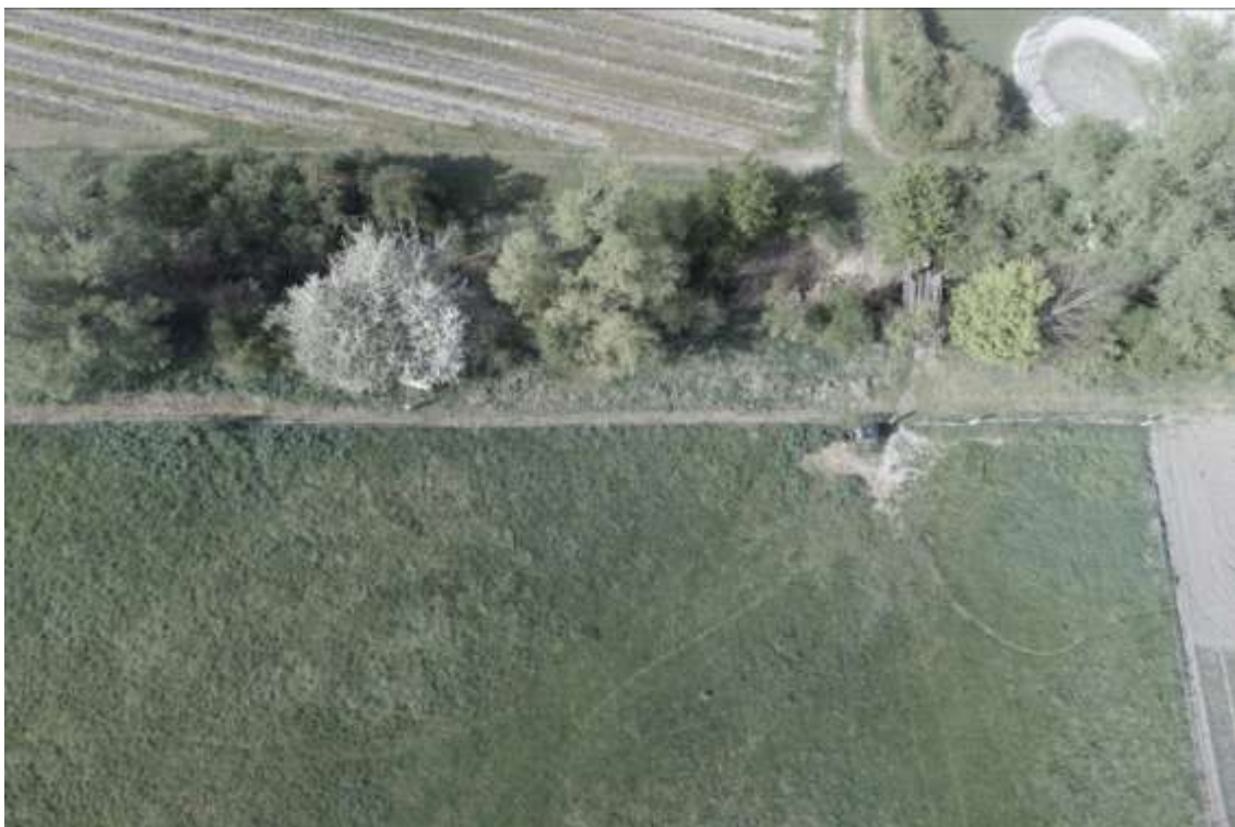
Bild 30: Die Brücke am Reiterhof von Süden
