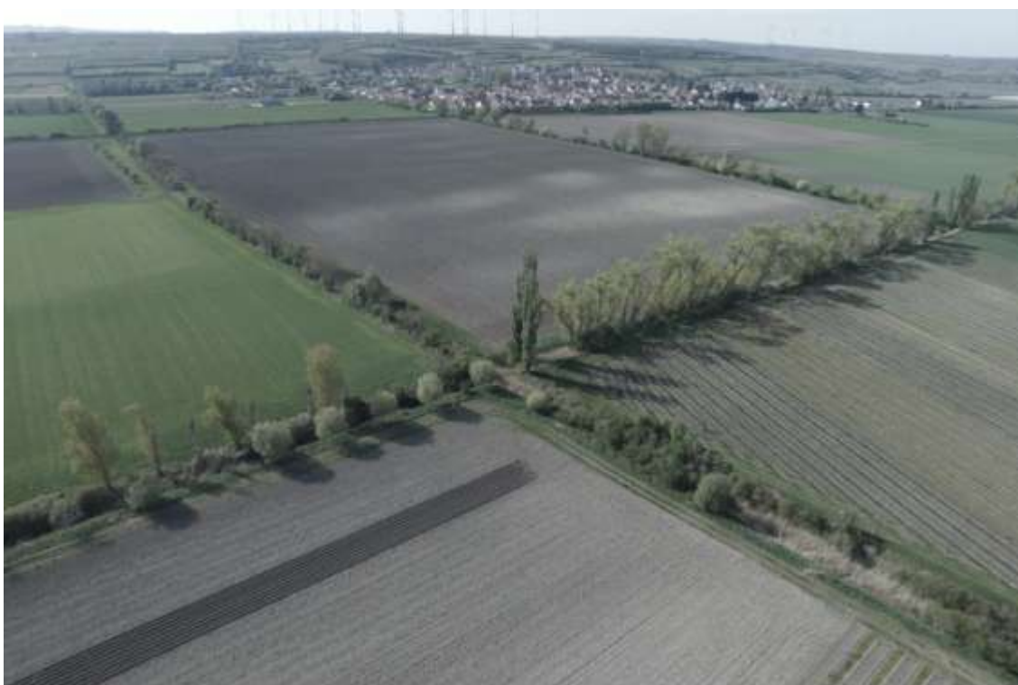
Bild 20: Das hangseitige Ende des zu untersuchenden Abschnittes (rechts unten), die beiden zuführenden Gräben (links unten und rechts oben) sowie der Rohrlachegraben oberhalb des zu untersuchenden Abschnittes (links oben)
