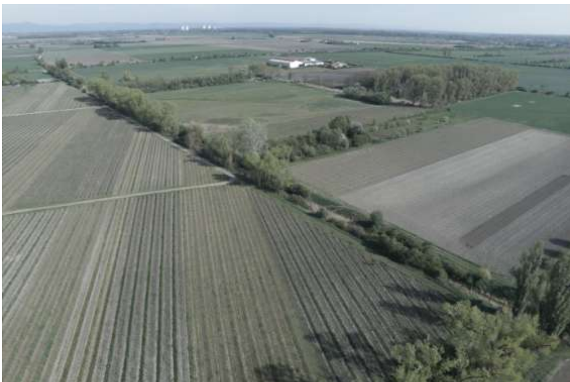
Bild 16: Der Projektabschnitt des Rohrlachegrabens von Nordwesten
