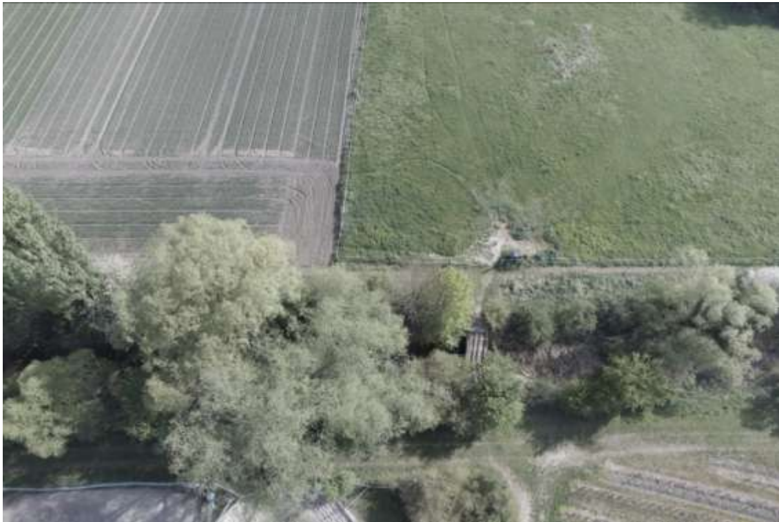
Bild 3: Die Brücke auf Höhe des Reiterhofes von Norden
